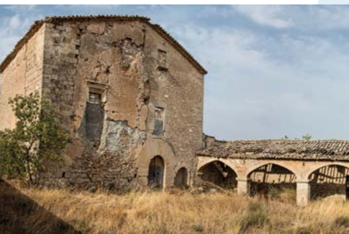
Molí de la Torre de Sant Martí de Maldà
