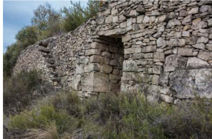
Marge de pedra a Rocafort de Vallbona
