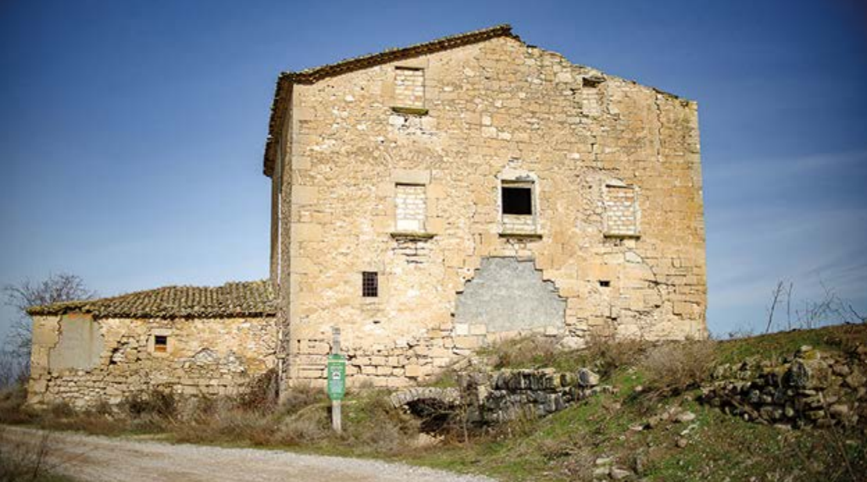
Molí de la Torre de Sant Martí de Maldà
