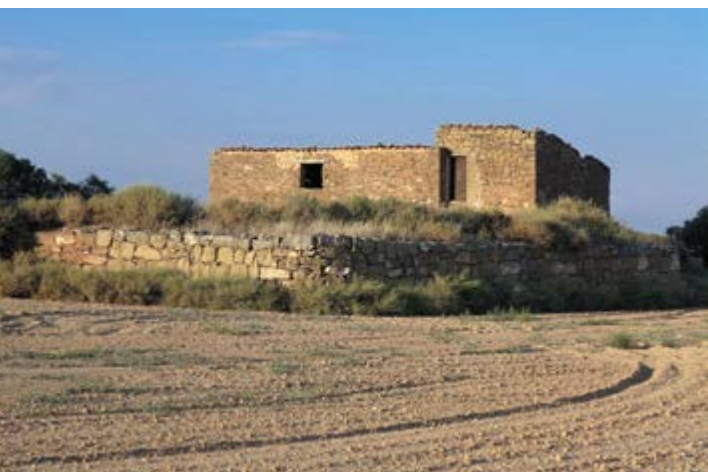
Marge de pedra a les Puelles
