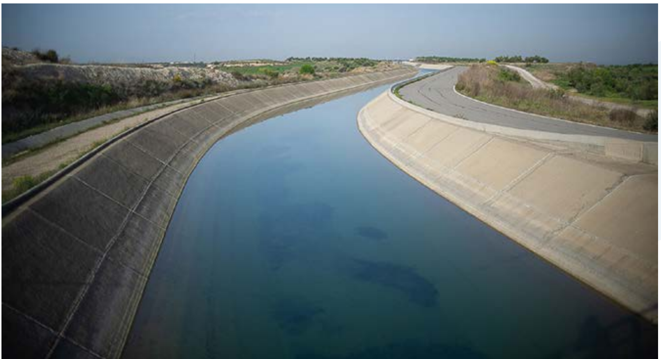
Canal Segarra- Garrigues a Sant Martí de Maldà
